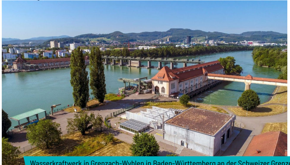
Wasserkraftwerk in Grenzach-Wyhlen in Baden-Württemberg an der Schweizer Grenze
